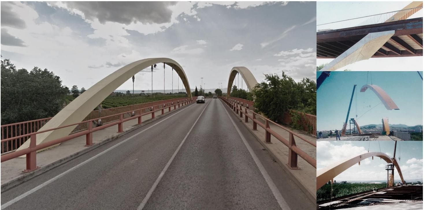
El puente sobre el río Júcar se ha resuelto con un doble arco con tablero intermedio mixto, fuertemente esviado.
